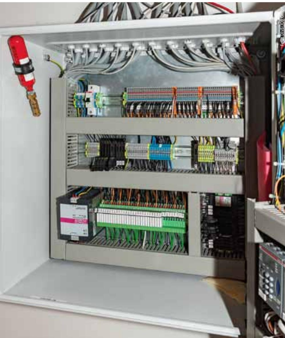
Löschmittelzylinder (oben links im Bild) lassen sich gut in Schaltschränken verbauen. Entstehungsbrände werden i. d. R. innerhalb des Gehäuses gelöscht.
